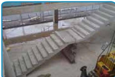
شکل ۳۷-۲- نمونه هایی از پله های بتنی
