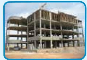
شکل ۲-۲- سازه های بتنی
