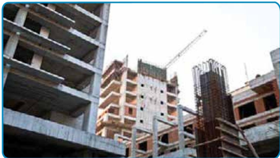
شکل ۱-۲- سازه های بتن آرمه
