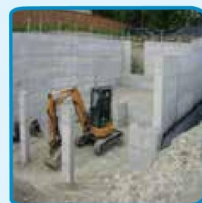
شکل ۲۱-۲- دیوار باربر
