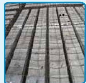
شکل ۲-۲۸- سقف تیرچه و بلوک
